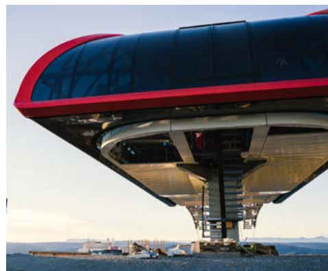
2021: Bygging av ny toppstasjon på Nesfjellet. Foto: Nikolai Jelstrup
