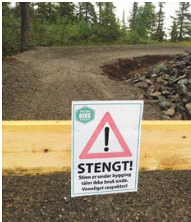
Vedlikeholdsarbeid i Trysil Bike Arena.
